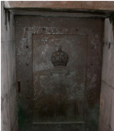
Descuido com o patrimônio histórico: Entrada da Cripta Imperial localizada abaixo do Monumento à Independência
