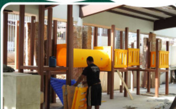
INSTALAÇÃO DE PLAY-GROUND NA COBERTURA DA PRAÇA DE ALIMENTAÇÃO
