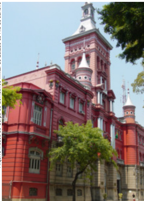
Edifício histórico do Corpo de Bombeiros Militar do Estado do Rio de Janeiro – CBMERJ
