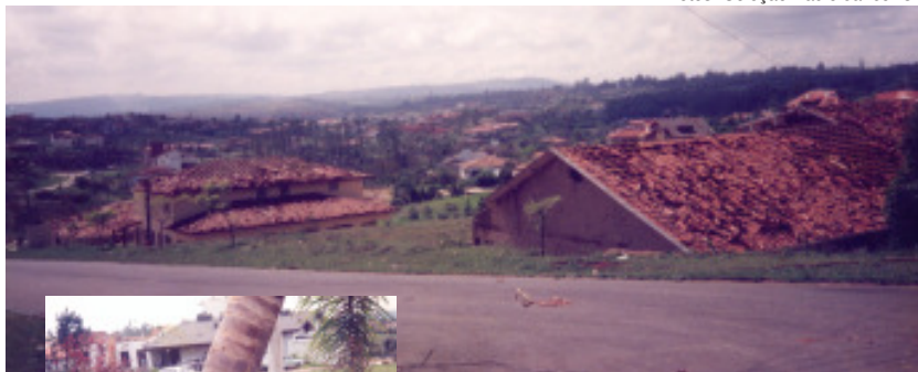
Tornado provocou destelhamento de casas e outros estragos no Condomínio Terras de São José; no detalhe, nessa mesma região, uma viga de madeira atravessou o troco de uma palmeira com a força do vento
