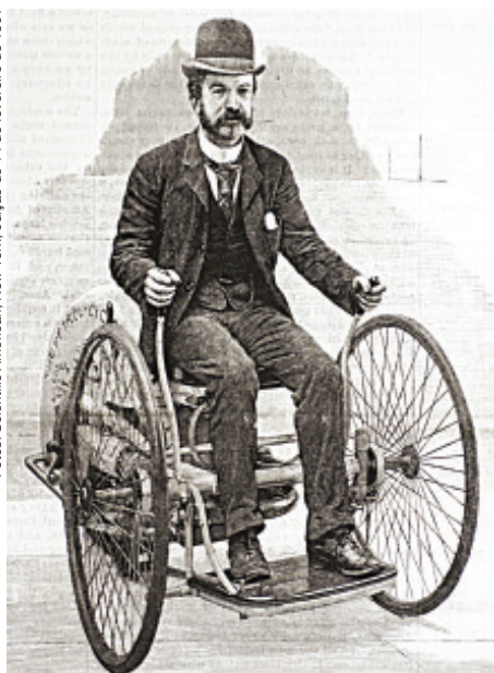
The Petrol Cycle, primeiro projeto comercial de uma bicicleta autopropelida concebido por Edward Butler na Inglaterra, em 1884. No detalhe, vista lateral do veículo
