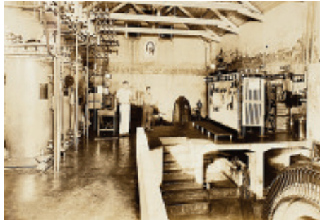
Vista interna da Usina Hidrelétrica São Pedro
