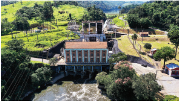
Em 2003, a Usina Porto Góes contou com obras de ampliação de seu potencial energético, passando de 11 para 24,3 de capacidade instalada
