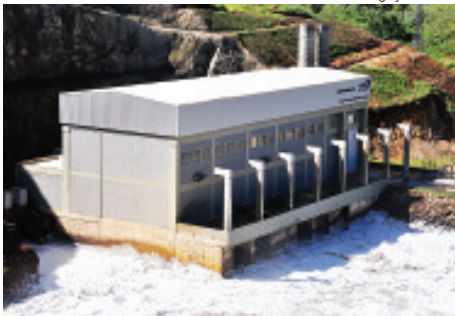
Pequena Central Hidrelétrica de Pirapora foi inaugurada em dezembro de 2010 com o objetivo de ampliar o parque gerador de energia da EMAE
