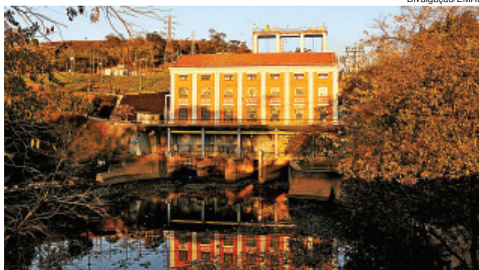
Com quase 100 anos de existência, a Usina de Rasgão está localizada na cidade de Pirapora do Bom Jesus
