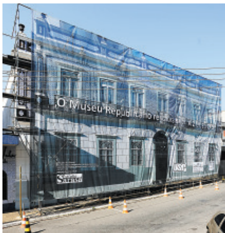
Vista do Museu Republicano em obras na época do restauro dos azulejos portugueses da fachada; a conclusão ocorreu em 2012
