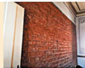
Parede interna do edifício do Museu da Energia
