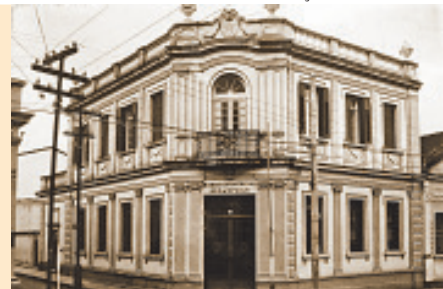
Na interseção entre as ruas Floriano Peixoto e Madre Maria Theodora, ergue-se um prédio construído em alvenaria no final do século 19. O edifício, que é um exemplo do uso de novos materiais construtivos, abrigou durante muitos anos o Banco Commercial do Estado de São Paulo
