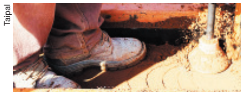
Apiloamento da terra no taipal
