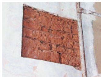
Exposição da taipa usada na construção foi deixada à mostra para que o visitante possa conhecer essa técnica construtiva
