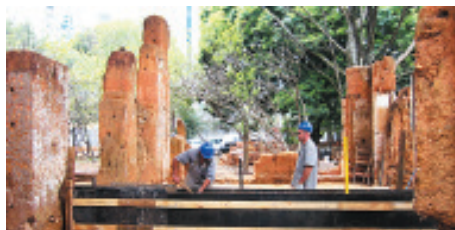
Casa do Sítio do Itaim Bibi restaurada; detalhe da restauração das paredes de taipa de pilão da Casa do Sítio do Itaim Bibi
