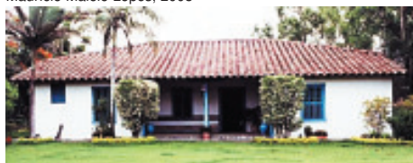
Casa da Fazenda Nossa Senhora da Conceição em Itu
