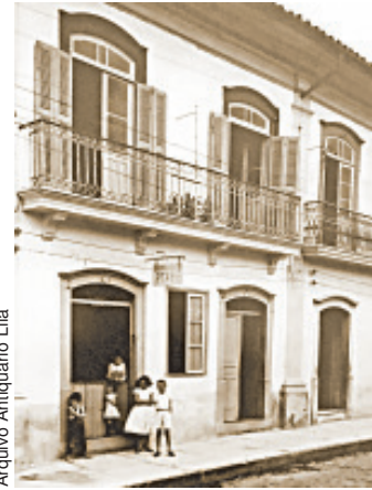
Fachada do sobrado do Antiquário Lila na década de 1940, quando no local funcionava, no pavimento térreo, a loja de máquinas PFAFF
