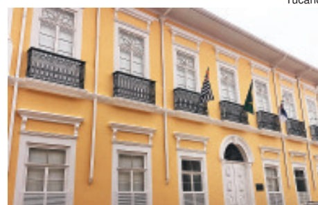
Fachada do prédio histórico foi recuperada pelo processo de restauro
