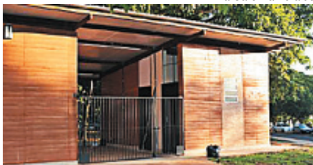
Edifício construído em taipa de pilão para a Biblioteca da Universidade Federal de Mato Grosso do Sul
