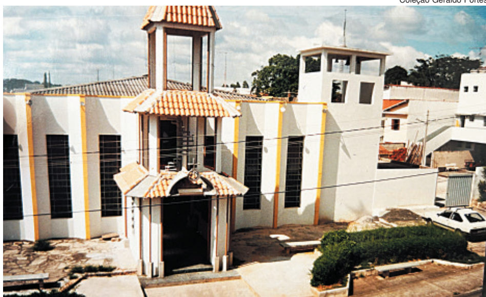
Fachada da Igreja São José antes da última reforma
