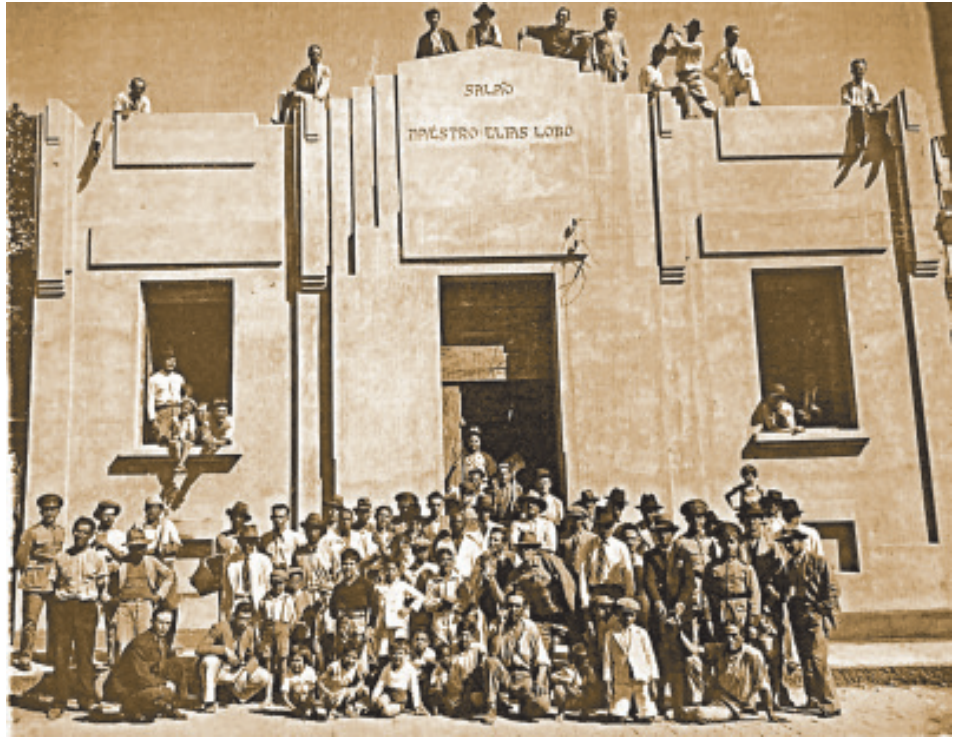
Construção da sede da Corporação Musical União dos Artistas contou com grande mutirão de colaboradores
