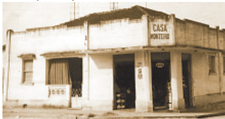
Tradicional Casa Monteiro, na esquina das Ruas Santa Rita e Pedro de Paula Leite. Atualmente, o prédio abriga o Bar do Bafinho
