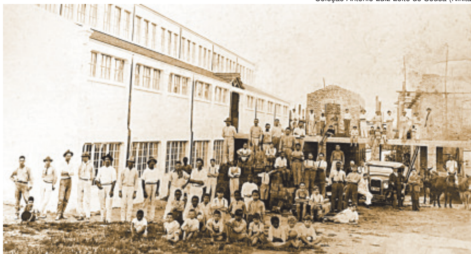
José Leite de Sousa (oitavo da esq. para dir.) trabalhou como pedreiro durante a obra de construção do prédio e, depois, tornou-se funcionário do IBAO até se aposentar, segundo sua filha Maria da Graça Sousa Borges (67 anos)
