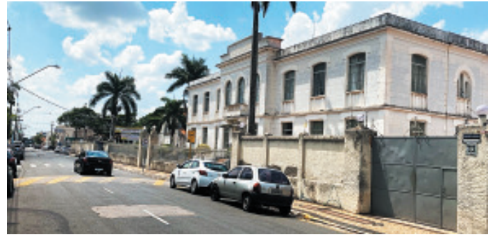
No prédio principal, em 2017, também foi realizada adequação e reforma geral na parte elétrica com a troca de toda a fiação, instalação de novas tubulações, circuitos, interruptores, tomadas, quadros de energia e cabos de internet
