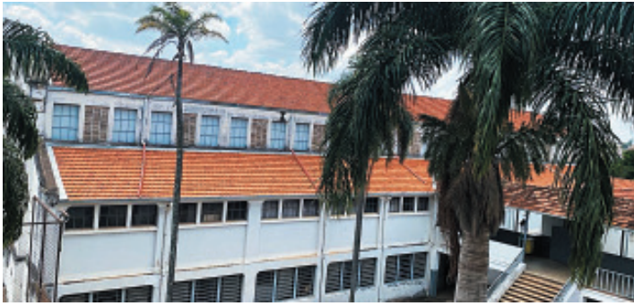
Na última grande reforma realizada em 2017 no IBAO foram restaurados a estrutura de madeiramento dos telhados, telhas, calhas e rufos do prédio principal, salão nobre e galpões anexos
