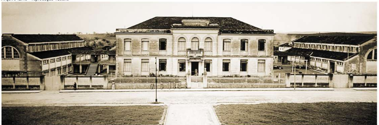
O projeto do prédio do IBAO foi assinado pelo renomado arquiteto Ramos de Azevedo em 1921
