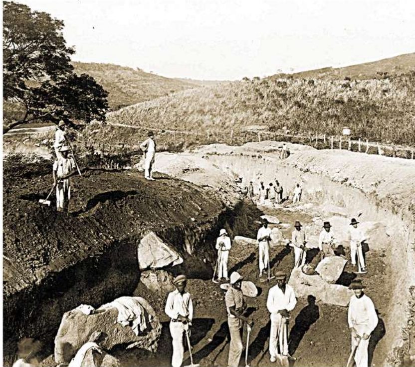
Com picaretas e pás, operários abriram a Estrada dos Romeiros há 100 anos. O registro fotográfico mostra trecho da estrada próximo à Fazenda da Serra
