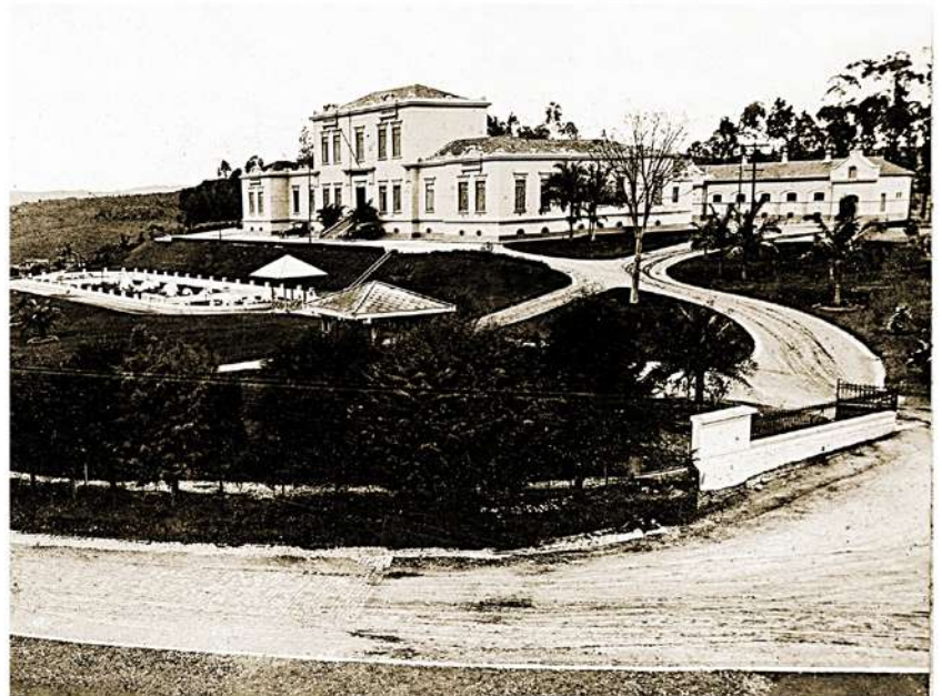
“Vista do Parque”, fachada do Prédio Central/Edifício Vital Brazil e serpentário
