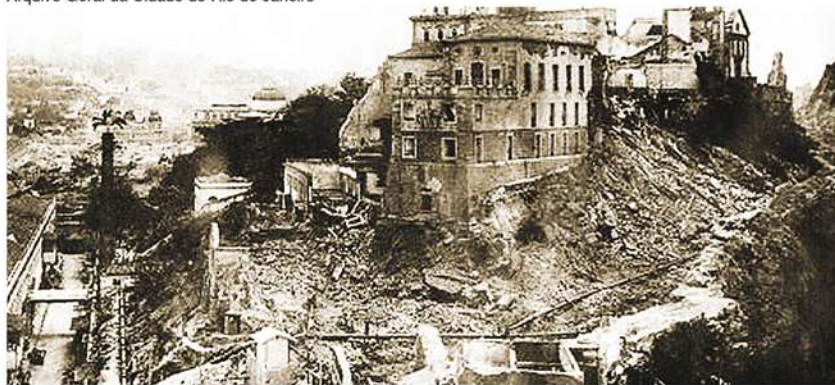
Morro do Castelo com a demolição em andamento, 1921
