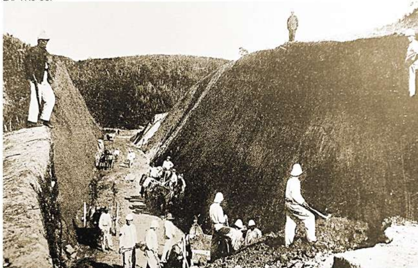
Guardas armados vigiam presidiários nas obras da Estrada dos Presidiários, 1917
