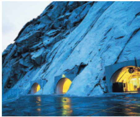
Fachada do Cofre de Registros das Montanhas de Granito, localizado em Salt Lake City, Utah
