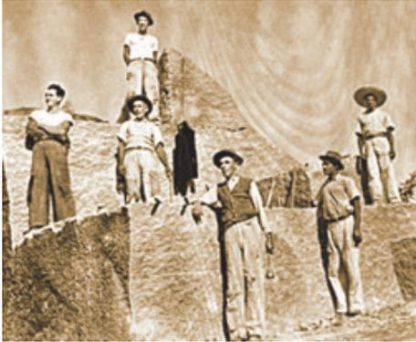
“Scarpellin”: artesãos italianos que, com técnicas tradicionais de talhamento de granito, construíram o canal e os edifícios da Usina das Lavras, produzindo blocos e encaixes precisos para paredes, colunas e fundações
