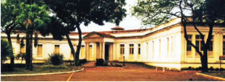
Fachada atual do Hospital Borges da Costa (2010), antigo Instituto do Radium, Belo Horizonte/MG
