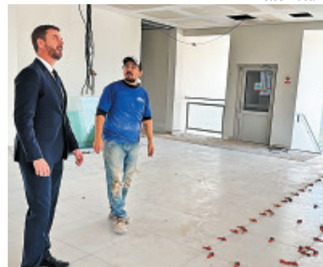
Tarossi ao lado do azulejista Geovane Justino (à direita), colaborador da empresa responsável pela reforma do prédio
